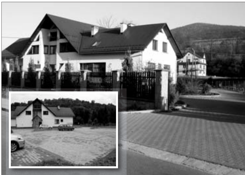
Chodnik i parking przy Ośrodku Zdrowia w Kasince Małej
