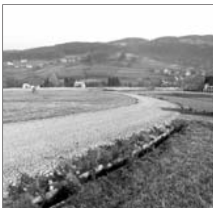
Remont drogi do os. „Żądłówka” w Kasince Małej
