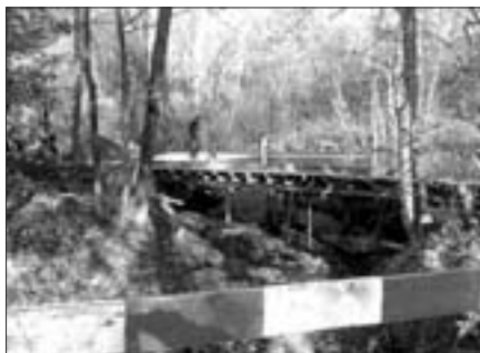
Przebudowa przepustu na most na potoku Kasinka w ciągu drogi gminnej Kasina Wielka – Gruszowiec
