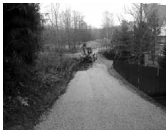
Remont drogi do os. „Pawlaki” w Łostówce
