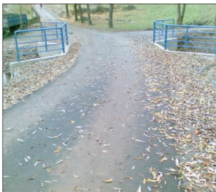
• TOWE Droga do osiedla Cierpiele
