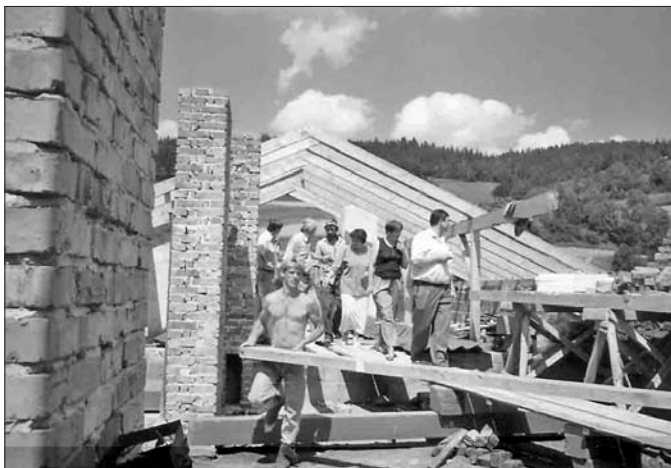
Budowa sali gimnastycznej
