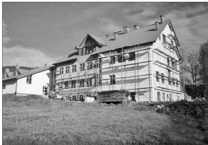
Termomodernizacja szkoły, 2003 r.
