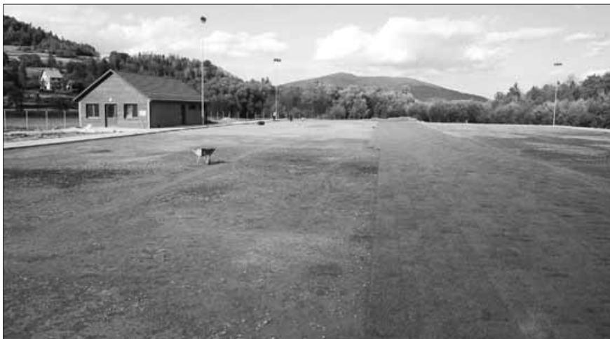
Budowa boiska sportowego w Rabie Niżnej
