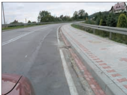
Chodnik przy drodze krajowej w Rabie Niżnej
