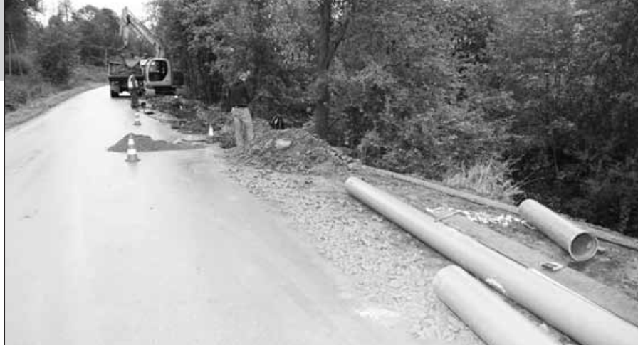
Budowa kanalizacji sanitarnej w Łostówce
