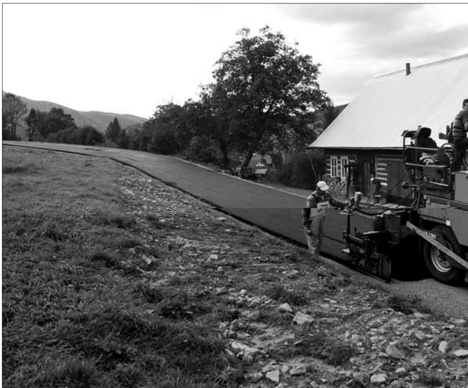
Budowa drogi do osiedla Bolisęgi w Kasince Małej
