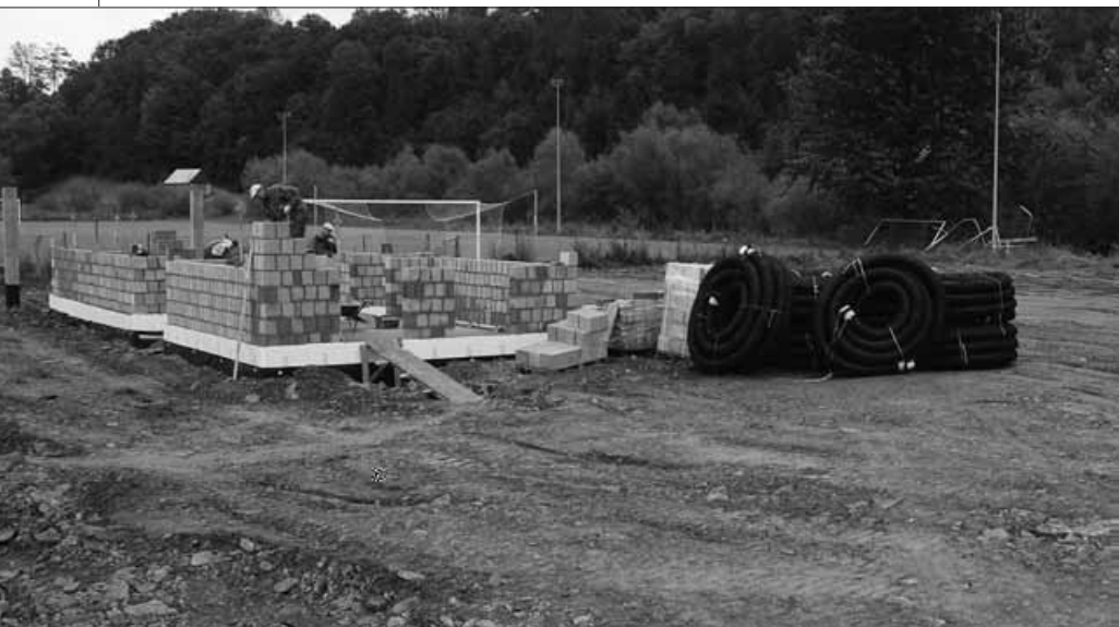
Budowa Kompleksu Orlik w Kasince Małej
