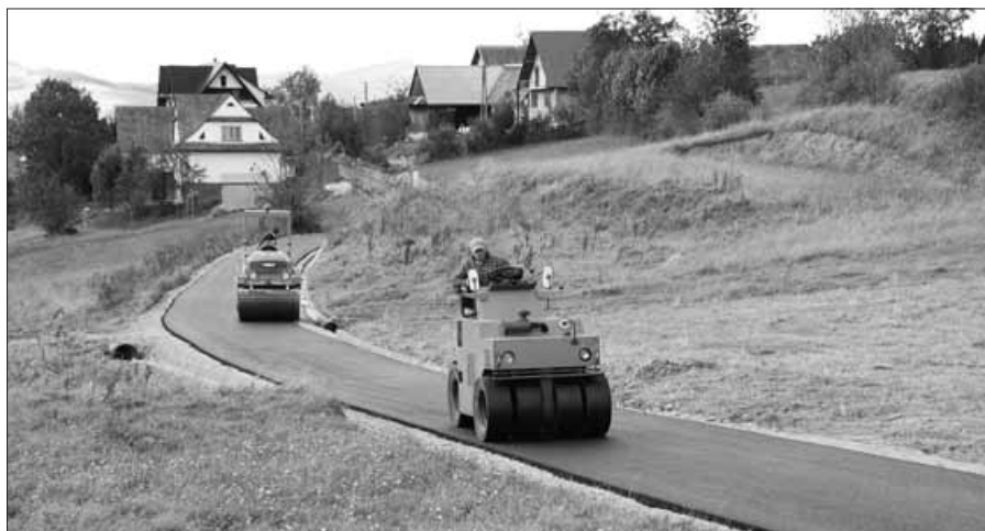
Budowa drogi do osiedla Chachatki w Lubomierzu
