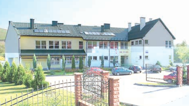
Wykonana nadbudowa Gimnazjum Nr 4 w Mszanie Górnej
