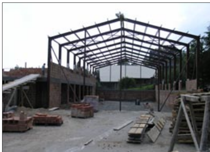
Budowa sali gimnastycznej przy Gimnazjum w Rabie Niżnej.
