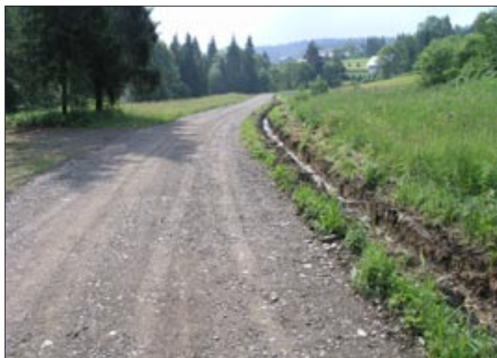
Budowa drogi do osiedla Rogi w Kasinie Wielkiej.
