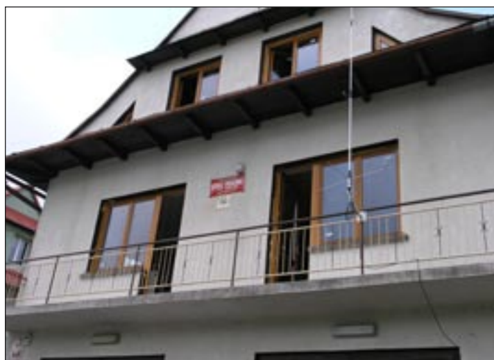
Termomodernizacja remizy OSP Mszana Górna.
