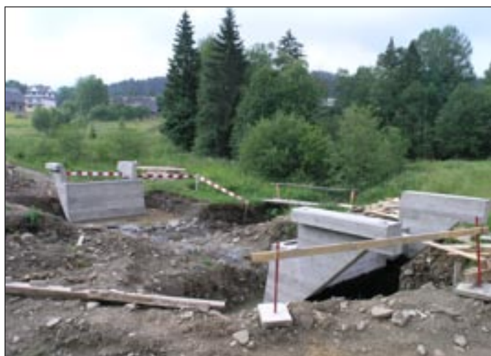
Budowa mostu do osiedla Wróble w Łostówce.
