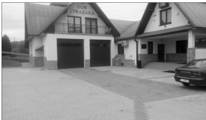
Modernizacja garaży i placu manewrowego przy OSP Kasina W.
