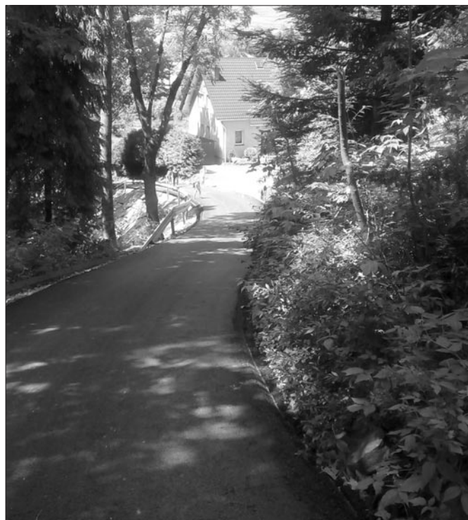
Droga na osiedlu Gobory w Łostówce
