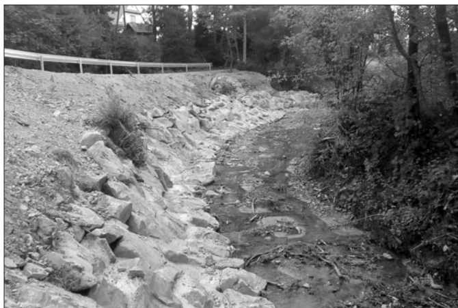
Zabezpieczenie drogi Kasina Wielka – Gruszowiec
