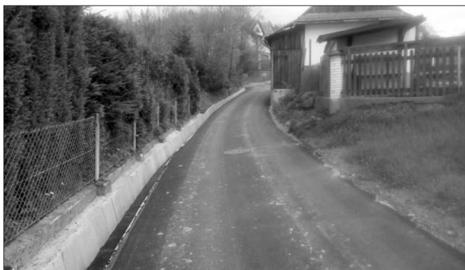
Droga na osiedlu Brzegi w Kasince Małej
