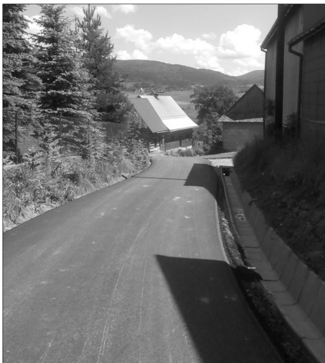
Droga na osiedlu Pyrze w Lubomierzu
