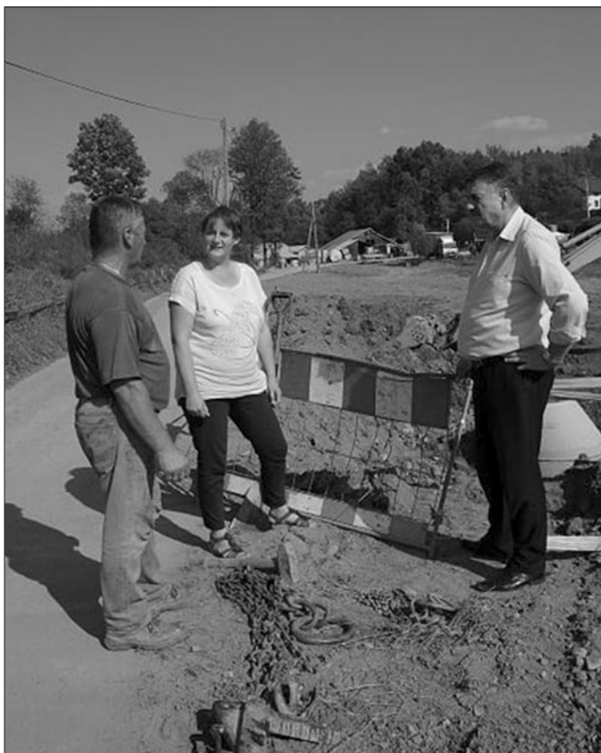
Budowa sieci kanalizacji sanitarnej w Rabie Niżnej
