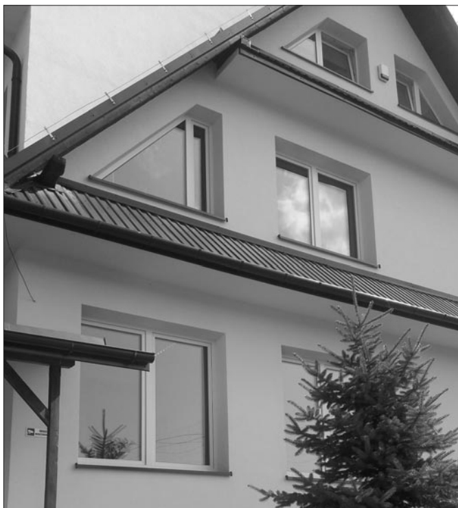
Termomodernizacja SP nr 3 w Kasince Małej
