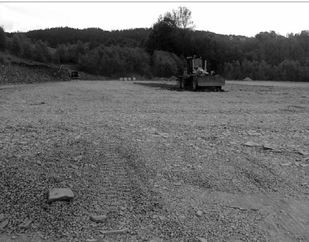
Budowa Boiska sportowego w Olszówce
