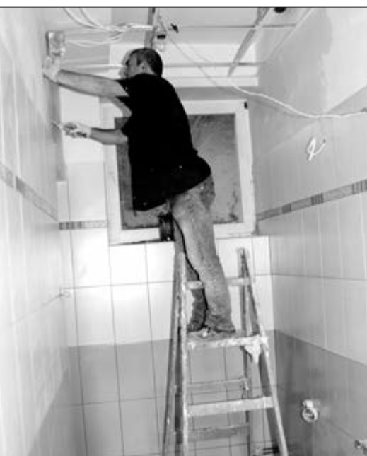
Remont w ZPO Kasinka Mała
