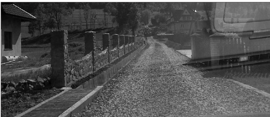
Roboty na drodze do osiedla Górnie w Kasince Małej – docelowo droga asfaltowa
