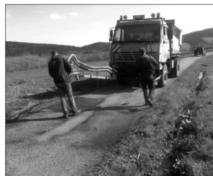
Remonty cząstkowe nawierzchni asfaltowych na terenie gminy Mszana Dolna
