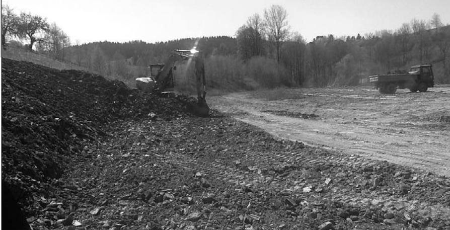
Budowa boiska sportowego w Olszówce
