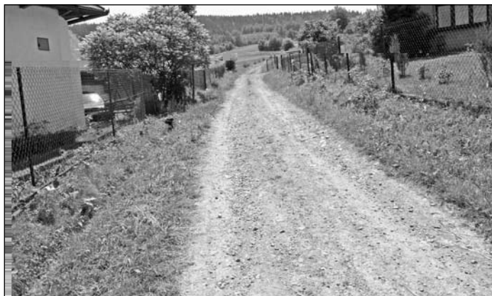
Droga do osiedla Ciepiele w Łętowie - przed modernizacją
