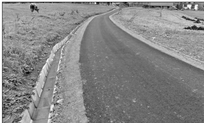
Droga do osiedla Ciepiele w Łętowie - po modernizacji
