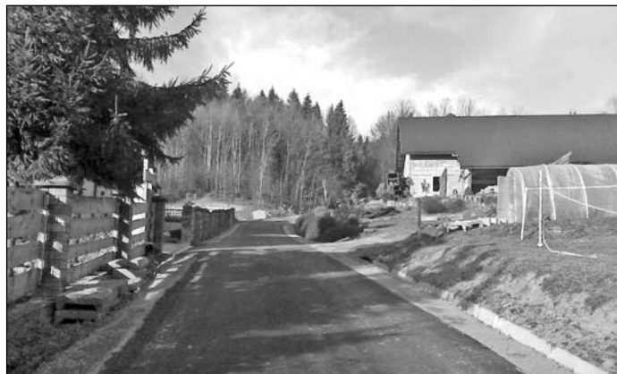
Droga do osiedla Karkulki w Łostówce - po modernizacji
