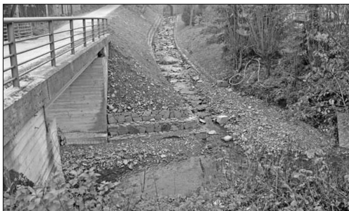
Zabezpieczenie mostu i drogi os. Krzystki w Łętowie
