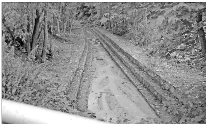
Droga Zarąbki w Olszówce - roboty regulacyjna na potoku
