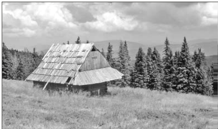
Stylowy szałas na polanie Mostownica (stan przed remontem)
