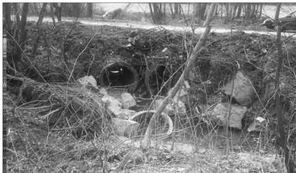
Przebudowa przepustu na most na potoku Kasinka w ciągu drogi gminnej Kasina Wielka – Gruszowiec
