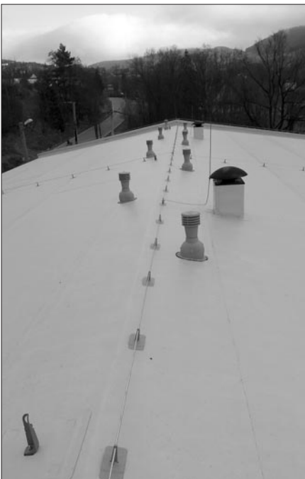
Wyremontowany dach sali gimnastycznej w Łętowiec
