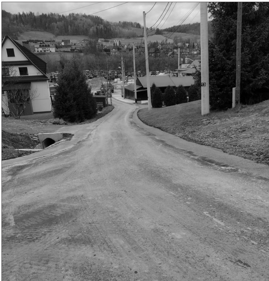
Zmodernizowana droga na osiedlu Janówka w Rabie Niżnej
