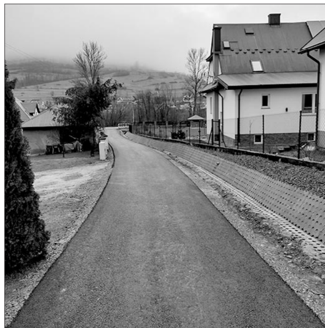
Mszana Górna – droga do osiedla Bielaki
