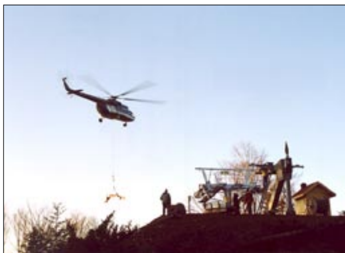
Śnieżnica - montaż kolejki.
