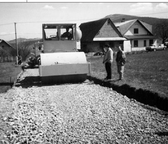
Budowa drogi do osiedla Pańskie-Podlesie
